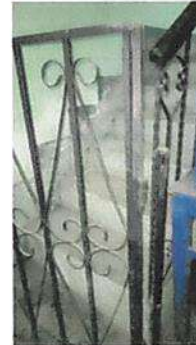
Foto 4: Instalar puerta de gradas
