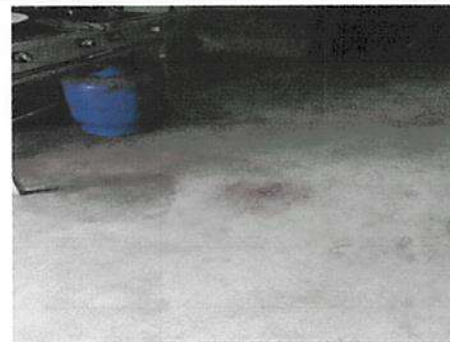
Foto 6: sustitucion de plancha de cemento por piso ceramico
