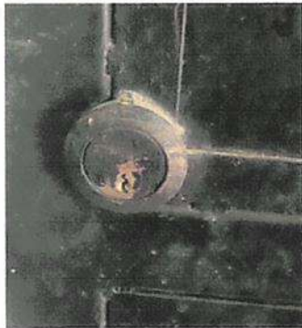
Foto 3: Cambio de chapa en cocina
