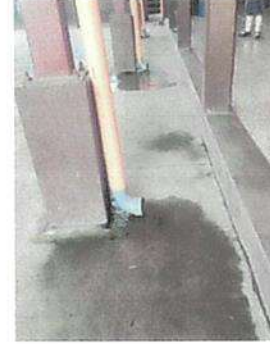
Foto 2: Unificacion de tuberia de agua pluvial en cancha
